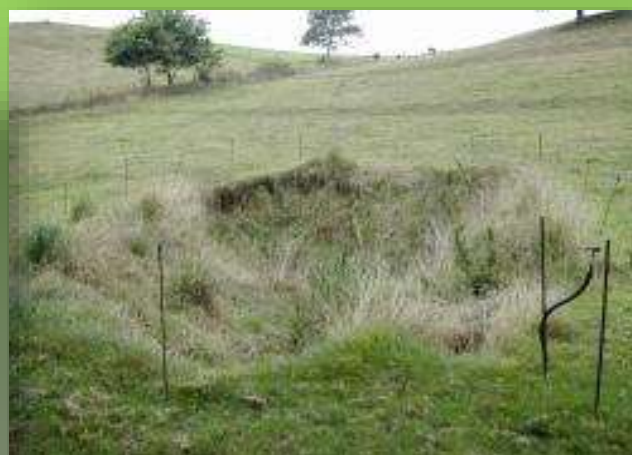
Cône d'effondrement d'une bétoire (crédit : SMBV Pointe de Caux)
