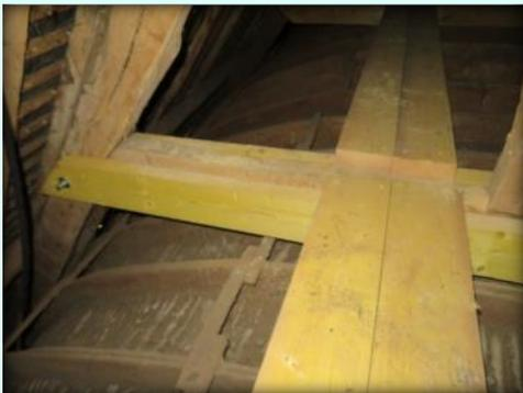
Ensuite il y a eu ce qui ne se voit pas, à l'intérieur pour la charpente de la nef et du transept-nord où la ferme de la nef a été renforcée, mise en place d'un chemin au sommet de la voûte d'un bout à l'autre de la nef. La voûte en pierre surmontée du transept-nord a été recouverte d'un plancher de travail.
