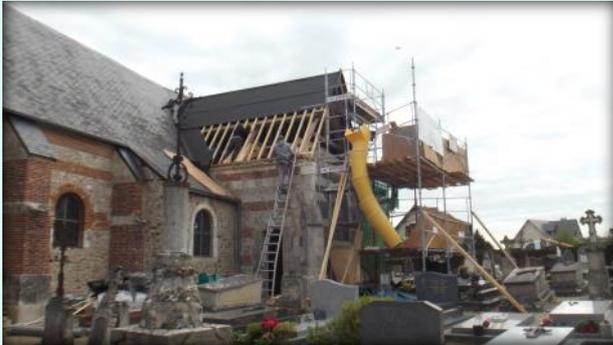
Une fois le raccordement effectué, le chevonnage et la mise hors d'eau.
