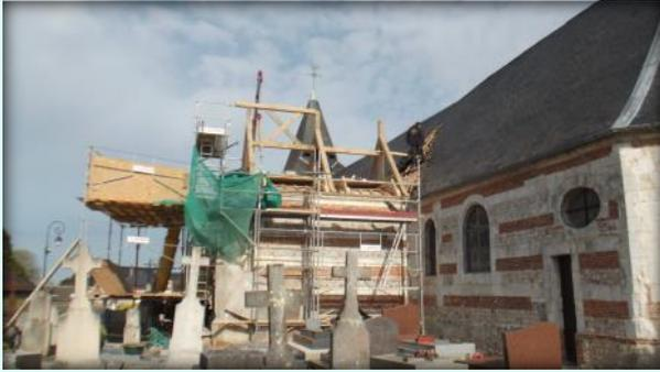
La nouvelle charpente, en chêne, prend forme. On peut voir qu'il manque un morceau de faitière... C'est un travail de précision pour se greffer sur la charpente de la nef!
